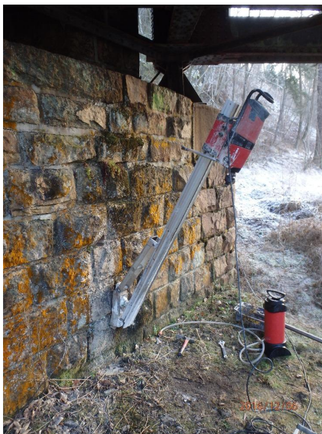
Obr. 3: Šikmý vrt do opěry O 01 (vrt č. 2)
