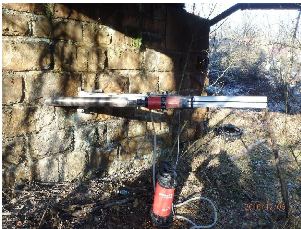
Obr. 5: Vodorovný vrt do opěry O 02 (vrt č. 3)
