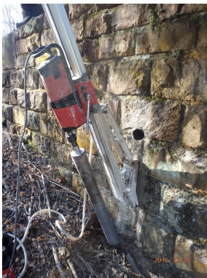
Obr. 6: Šikmý vrt do opěry O 02 (vrt č. 4)
